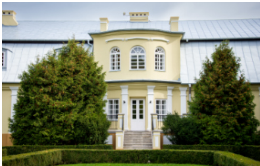
Po remoncie Dworek Olszewskich ponownie zachwyca swoją architekturą
