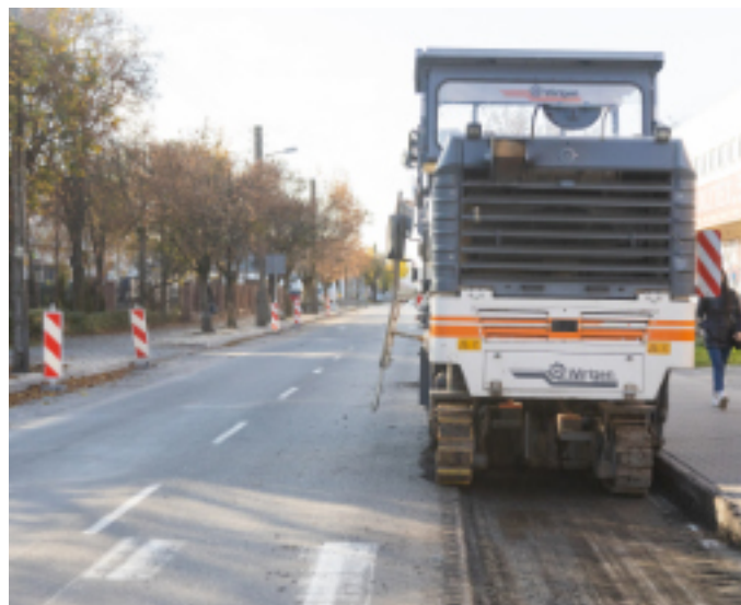
Remont Czyżewskiego poprawi komfort jazdy kierowców
